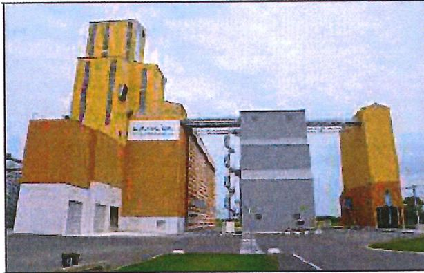
Le silo d'une hauteur de 47 mètres contient 16 cellules de stockage.
